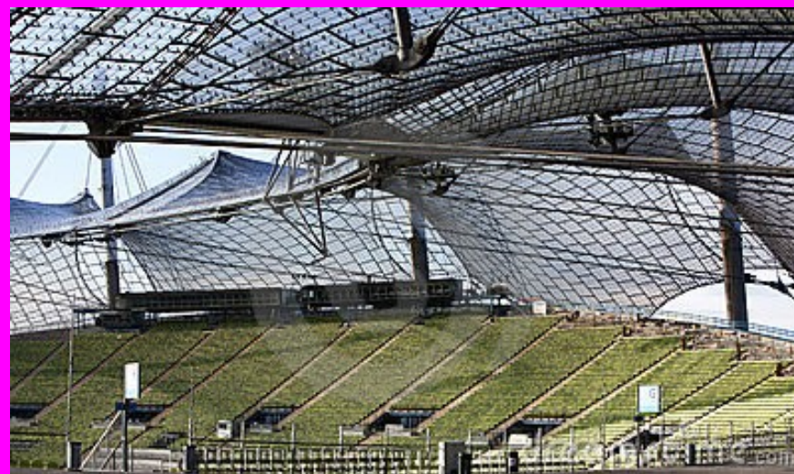
Copertura dello Stadio Olimpico Monaco di Baviera.
